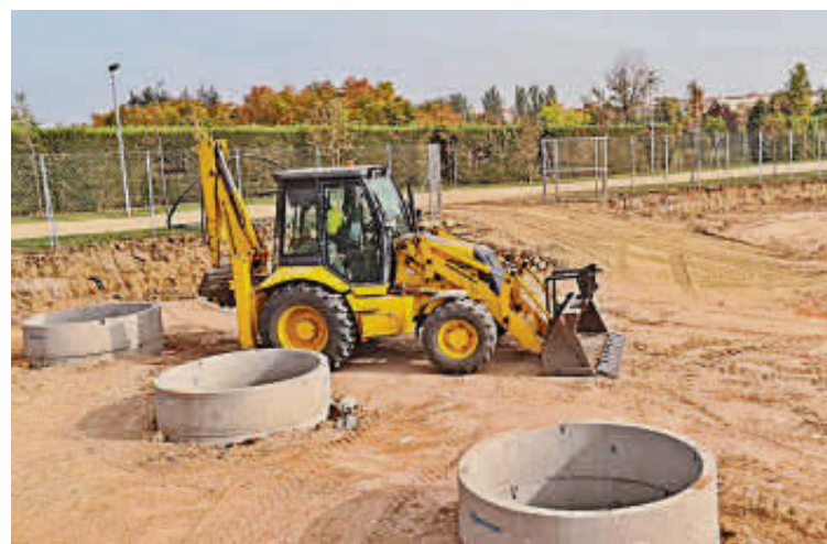
Comienzo de las obras en el parque de los huertos urbanos.
